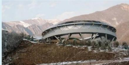
国家雪车雪橇中心采用世界顶尖的赛道设计，赛道底部是一个 U 形槽，U 形槽内布置钢筋混凝土摇摆柱支撑赛道。赛道设计成复杂的空间三维曲面，其找形与内部设置的卡具息息相关，建设弯道时，会按照赛道的形状布置相应的卡具，在卡具上铺设制冷管（卡具和制冷管道是赛道的骨架和血液），然后再铺设经过特殊处理的钢筋网片，最后设置找平管。并采用喷射混凝土成型。在赛道外侧设置保温层，冬季比赛和训练时赛道内侧浇筑 50mm 厚的冰面。
