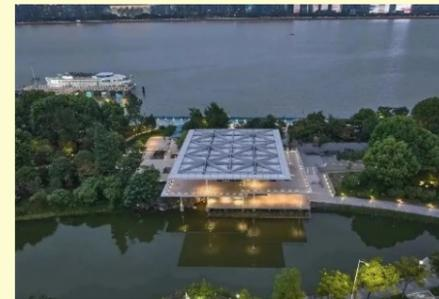
润石驿位于低碳博物馆前芳草台地临改造人工湖一侧，以休憩，观景，便民服务为主要功能。原有主体结构为钢筋混凝土结构。利用原有主体结构的混凝土框架及剪力墙进行抗侧，增设钢结构柱均为重力柱，采用圆形棱形柱，柱底部采用球铰节点，以进一步减小柱子的截面尺寸。根据悬挑梁的受力形式，屋盖采用倒T型钢梁，钢梁布置为伞形，实现屋顶结构的大悬挑，同时钢梁间设置细小的钢管，保证钢梁的稳定，满足建筑立面和俯瞰的效果要求。
