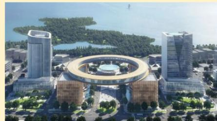
“荣耀之环”是滴水湖金融湾首发项目最富戏剧张力的标志性建筑,是一个直径153m的巨构圆环“飘浮”在临湖的4栋46m高的塔楼上,环顶高度56.15m,圆环结构高度6.6m,宽度14m,四个塔楼的32根钢柱作为荣耀之环支撑点,支座之间最大跨度120m,钢结构工程总重量1万余吨。
