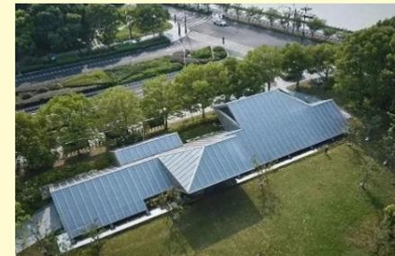
大桥驿位于海创中心绿地内，设计以对角相接的钢片形成空间结构。钢结构构件作为建筑表达的要素裸露在外，三角形的支撑形式塑造了稳定的结构骨架感，并与远方的钱塘江大桥相呼应。
