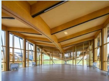
主体结构材料选择绿色负碳的木材，与设计概念非常匹配，但木材受压性能好、抗拉抗弯性能弱，木结构梁柱连接节点难以满足刚性连接要求，为结构设计增加了难度。屋脊主拱需要承担屋面一半的荷载，如果采用传统框架结构，梁柱节点处需传递较大弯矩。由于木材的特点是受压性能优异，这种以弯曲为主的受力方式会导致主拱及柱截面尺寸非常大，并且木结构连接节点无法达到足够的转动刚度，因此需要通过建筑与结构的融合设计来减小主拱承担的竖向荷载，同时形成有效的纵横向抗侧体系。
