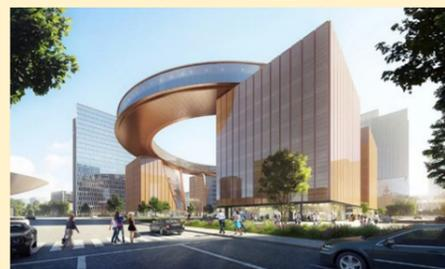
受建筑功能要求制约,外围视线应无遮挡,本项目圆环结构不可避免地存在重心偏置与刚度迥异等特征,进而导致大跨度圆环结构产生弯-剪-扭等复杂力流传递与非均性形变姿态。此外,圆环结构与塔楼结构间的联动传力与协同抗震,圆环结构与幕墙
