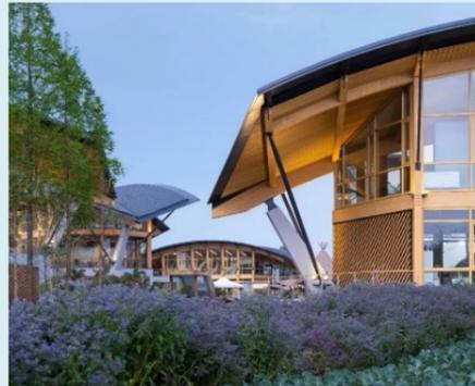
对于每个“叶片”的横向抗侧体系，结构设计摒弃了传统框架结构中刚性连接节点的概念，结合木结构连接特点，将柱顶节点设计为铰接，使框架柱变成了摇摆柱。一方面，利用方案中的斜向钢杆件，与木柱、悬挑梁形成稳定的三角形关系，同步转变为结构主要受力拉杆，像跷跷板一样撬动跨中主拱，缓解主拱竖向荷载，减小主拱变形；另一方面，钢拉杆作为支撑构件，与木柱、悬挑梁组成三角形刚架，弥补了柱顶铰接的不足，形成了更为有效的横向抗侧力体系。这样的构思既保证了结构整体的稳定，也使构件尺寸更为纤细。
