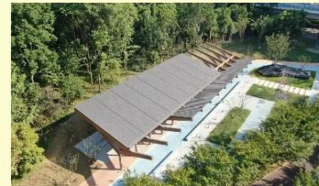
赏樱亭，结合场地形成较丰富的高差，提供多角度的樱花欣赏点。沿着单体长边方向，通过钢梁钢柱之间的刚接，形成抗侧力体系，沿着单体短边方向，三根胶合木梁拼接形成三角桁架，以解决接近 $8m$ 的重力荷载问题，针对抗侧问题，于两侧悬挑钢梁端部设置拉索，同时对拉索施加预紧力，在侧向水平力作用下，形成力偶，与钢柱共同抵抗侧向荷载作用。
