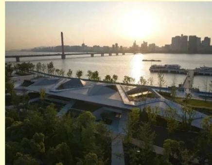
云渡驿所在的场地原为钱江三桥东侧的邮轮奥体码头，紧邻亚运会主体育馆。整个结构可看成是四个落地菱形体块的重复排列，每个体块均包含一对平行斜杆及一对V型斜杆，以四个体块托举屋面。屋面体系为三角形斜交网格，在减小结构自重的同时增强杆件间的相互联系，形成整体性较好的空间结构，以实现最大 $15m$ 的悬挑。
