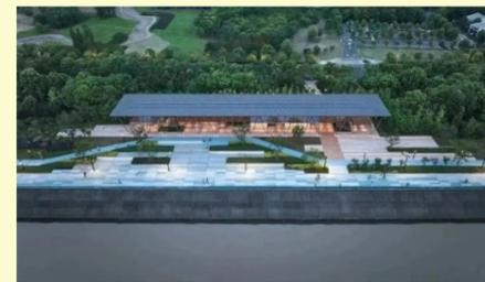
长亭驿位于杭州市滨江区钱塘江南岸，是一座两层的钢木组合结构。长度约 $100m$ ，宽度约 $15m$ ，屋架为 $6m \times 6m$ 的米字形胶合木梁单元组合，支承屋架的为三根一组的空间V形钢柱，二层楼面由连接于钢柱两侧的水平胶合木梁承托，同时结合屋面向下设置的钢拉杆进行吊挂。
