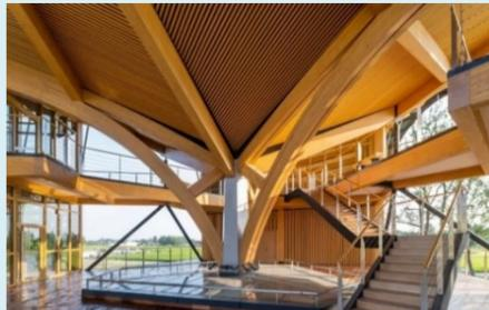
$33m$ 跨度主拱的结构找形也是设计中的重点问题。设计师根据主拱跨度、高度、拱轴曲线半径、下部净空要求等制约因素，结合基因遗传优化算法，以结构的最小应变能为目标，通过迭代计算自动寻找最优解，实现了建筑“形”与结构“力”的完美结合。“以力塑形，以形驭力”——青苗由此破土而生。
