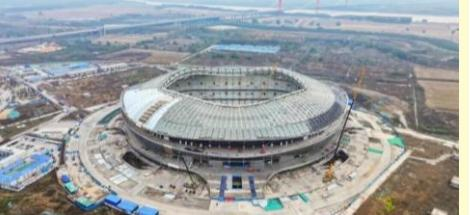
段，优化并提出了新的、精度更高的钢结构施工分析算法，同时强调施工过程中的快速检测与动态纠偏，通过借助 3D 扫描仪等技术，快速获取施工阶段的钢结构形态，进而与理论模型进行快速对比，提出施工过程的实时纠偏措施，形成针对复杂钢结构系统的闭环管控。
