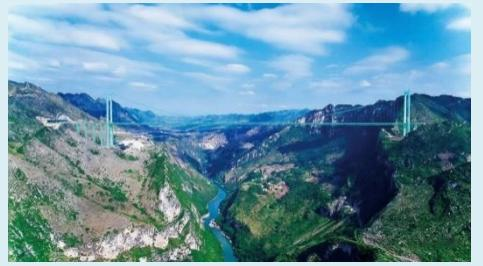
桥面至水面距离为 625m，为世界最高桥。主桥采用 1420m 双塔单跨钢桁梁悬索桥，桥面宽度 25.5m，缆跨布置为 245m+1420m+495m，主缆中心距 27m，垂跨比 1/10。
