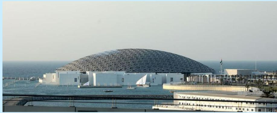
穹顶直径 180 米、高度 36 米。穹顶主结构为钢结构双层网壳，网格为三角形，结构层高度为 5 米。网壳构件为箱型截面，节点为螺栓连接装配式构造。网壳分为 85 个预先组装的超大尺寸单元，重量高达 50 吨，现场将各单元吊装就位后拼接在一起。
