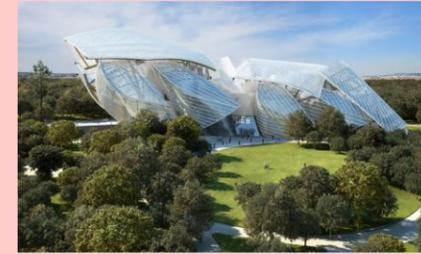
十二片曲面帆形屋面面积共 13500 平方米，由木框架和钢结构组成的骨架支撑。木框架采用曲线胶合木大梁通过螺栓节点连接，长度从 3 米到 25 米不等。最大的一片覆盖 3000 平方米，高度在平台以上 25 米。
