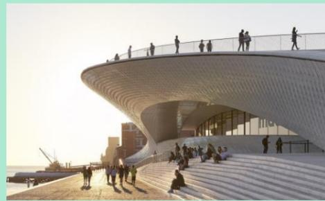
葡萄牙建筑中有使用陶瓷的丰富传统。整个建筑的外面一共贴了 15000 块三维瓷砖，每一块都可以独立活动，随着太阳的变化，建筑上光影交错、瞬息万变。
