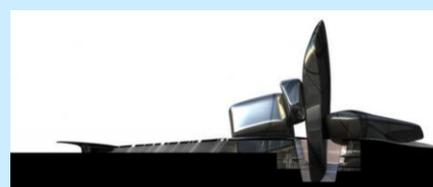
项目总建筑面积10万平方米，其中包含约45000平方米的各种文化设施，有礼堂、电影院、图书馆、展览馆、博物馆和档案馆。整个建筑的表皮被总长350km的曲线不锈钢管包裹。
