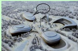
速滑馆平面呈椭圆形，长轴 219.4m，短轴 132.3m，建筑高度 33m，建筑面积近 2.88 万平方米，坐席数 3080 个。
