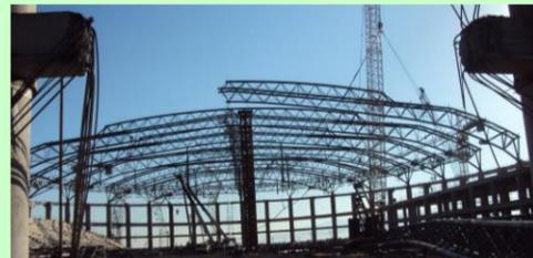
索头节点处杆件数目多，连接和受力较复杂，设计了铸钢节点，对节点进行实体建模有限元分析。
