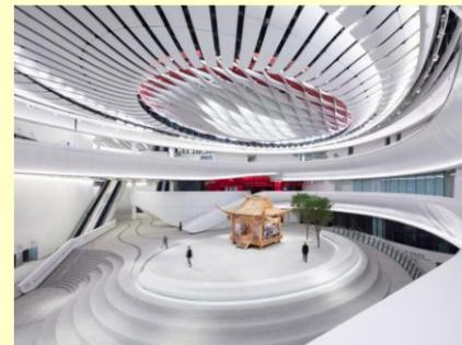
架空剧院主体结构为钢桁架，屋面采用曲面网壳结构。外幕墙使用钢结构框架和铝板。
