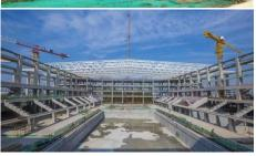
游泳跳水馆钢屋盖于 2018 年 8 月 9 日开始第一次滑移,经历经 18 次"高空 累积滑移"完成了 151.2m 滑移距离,于 2018年10月8日顺利滑移到位。
