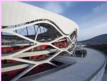
枣庄体育场是目前国内最大的平面椭圆形、空间马鞍形索桁结构之一，项目荣获鲁班奖和中国钢结构金奖。该工程应用大型弧形钢结构和大跨度索膜结构，这是继鸟巢、水立方之后，对该技术的又一大规模使用和探索。屋面采用大跨度车辐式索膜结构体系，索系由 320 根索组成，单根索最长达 240 米。现场采用地面组装后一次整体提升到位的施工方法，施工难度极大。外围护采用镂空弧形拉花钢结构，立面与地面水平夹角呈 80°。406 个双曲面弯扭构件上下弯曲且左右扭转，纵横交叉、十分复杂。
