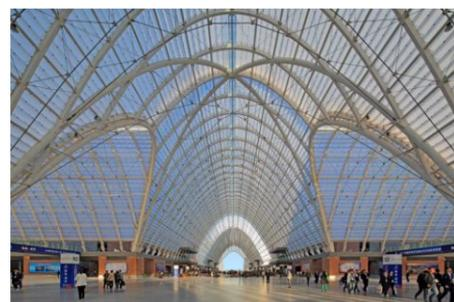
下部主体结构为混凝土框架体系，地上一层，局部设置一层地下室。十字展廊屋盖结构为预应力索拱结构，索拱平面外顺柱面网壳沿纵向利用高强钢拉杆通长设置交叉支撑，以保障索拱面外的稳定。
