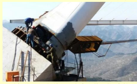
桥面梁和主拱施工平衡索及其工装(实拍)
