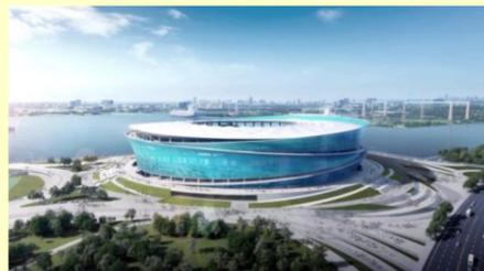
设计理念为“炫彩叠浪”。建筑立面定妆色“海洋蓝”，顶棚呈白色。从造型上看，看台上方的屋顶是一个放射状的环形杆壳结构，屋顶的表面接近圆锥体。建筑外部结构螺旋上升，辅以 2.2 公里长的螺旋坡道。预计坐席容量 63000 座。
