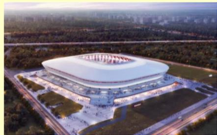
设计理念来源于中国传统瓷器，外观好似一块精美的陶瓷器具。屋盖为预应力轮辐状张拉体系，白色屋盖内圈采用半透明阳光板，将使草皮得到充足的日照。球场坐席容量 33000 座，已于 2020 年 9 月完成阶段性交付，预计 2021 年上半年完工。
