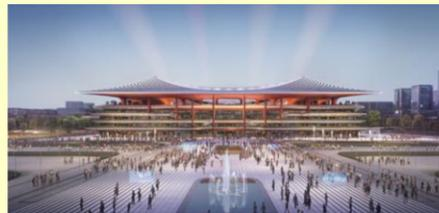
设计融入了“周秦汉”高台建筑的元素符号，通过大跨度的屋檐和通高的立柱，将西安历史文化底蕴的内容巧妙的融入设计之中，通过现代时尚的流线型的建筑语言重新诠释了中华的悠久文化。结构方案中创新提出了环壳钢结构金属屋面和双层双向索网的屋面结构。预计坐席容量 59000 座。
