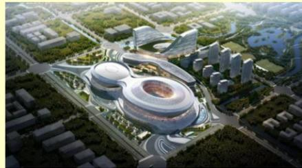
体育场整体造型好似四川的盖碗茶，足球场是茶杯，体育馆是茶盖，下部的大平台是茶托，预计坐席容量 60000 座。其采用的大开口索穹顶结构属国内首创、世界第一，索穹顶结构最大悬挑跨度超过 60 米，目前已顺利完成 ETFE 膜结构封顶。
