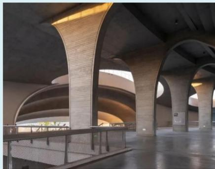
混凝土结构之上是由钢结构支撑的“光冕”风雨罩。风雨罩仅由 9 个落点支撑于看台之上，落点之间的最大跨度达到 95 米，让视线可贯穿体育场内外，空间显得更加通透开阔。
