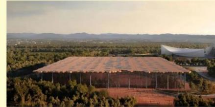
北京副中心图书馆项目的建筑方案由斯诺赫塔建筑事务所（Snøhetta）和华东建筑设计研究院有限公司（ECADI）组成联合体共同设计，展现了一种全新的图书馆设计理念。为了将整个建筑与周边环境融为一体，建筑师设计了两座连绵起伏的山体作为主要功能载体，并在建筑的内部和外部空间之间创造了一个连续体。两座山体被一片由 144 棵参天大树支撑起的茂密“森林屋盖”遮挡，每棵大树的设计灵感来自银杏树（公孙树）叶片。森林景观与图书阅览区融合，让身处建筑物内任何一个角落的读者，都会享受到“山间树下”的独特阅读体验。
