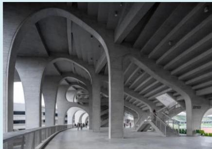
体育场南北主要出入口由一圈一圈的拱形混凝土薄壳排列而成，最大跨度近 40 米。
