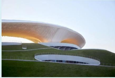
60 组混凝土片墙柱支撑起了整个体育场。裸露的木纹清水混凝土片墙摒弃了内外装饰层，既是结构，又是建筑本身。
