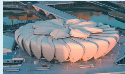
网球中心“小莲花”采用空间桁架钢结构，让下半部分的 24 片“小花瓣”在视觉上构成了相对独立的效果，实际上却是一个整体。
