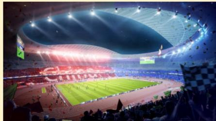
体育馆内圈两个月牙区域要求透光率高,故采用铝合金结构体系,外覆轻薄采光板材料,这在国内十分罕见。此外,体育场看台区域南侧建筑为开阔、通透效果,结构上通过钢拱桁架实现约143米的无柱大空间。
