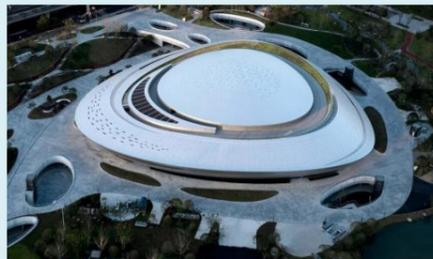
场馆以“星际漩涡”为设计理念，三条主步道作“骨架”，环绕核心旋转上升，形成双曲面异形结构，宛如星云中的恒星。建筑外表皮采用自洁型阳极氧化铝板与透明 LED 玻璃幕墙组合单元，天窗采用电致变色玻璃，整个建筑充满着科技感、未来感。
