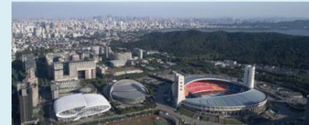
体育场主体结构平面呈圆形，采用框架-剪力墙结构，直径为 245.5 米，南北两座吊塔为核心筒结构，高度均为 88.5 米。钢屋盖的外环平面为圆形，周长为 781 米；内环平面为椭圆形，周长为 572 米。南北两座吊塔均由东西两肢组成，每肢吊塔上布置有 9 束钢索，四肢吊塔共 36 束斜拉索。斜拉索一端锚固于吊塔中，另一端锚固于内环钢箱梁中。屋盖网架为类正方四角锥形式的焊接球节点网架。钢屋盖的受力体系由斜拉索、外环混凝土箱梁、内环钢箱梁和两侧的吊塔组成。
