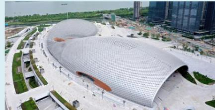
场馆分为体育馆、中央大厅和游泳馆，整个屋盖通过中央大厅将两大功能区屋盖连成整体，东西长约 600 米，南北宽约 360 米，钢屋盖最大跨度为 164 米。中央大厅为斜交斜放异形自由曲面单层网壳结构，体育馆和游泳馆屋盖为斜交斜放变厚度双曲鼓节点双层网壳结构，并在东西两侧设有单层悬挑网壳结构，总用钢量约为 2.5 万吨。
