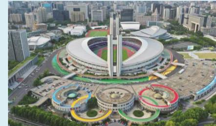
场馆改造工程对屋面板进行了翻新，对拉索和钢架进行了检测修复。并在二层外围修建了一圈立在半空中的橙红相间“腰带”——黄龙空中跑道。
