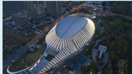
场馆根据轮滑运动的特色，采用“轮滑飞旋”的理念，场馆下部结构体系采用钢筋混凝土框架，上部采用大跨度钢结构屋顶，构成了一个独特的“旋风陀螺”，屋顶纵向跨度为 136 米，横向跨度为 78 米。轮滑馆屋盖采用铝镁锰金属屋面。
