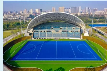
“伞架”由钢结构构成，“伞面边缘”采用 80 米的大跨度空间弯曲钢管拱架结构，是通过好几条直钢管进行扭曲，扭曲之后再弯，做完造型再现场拼接。屋顶外覆厚度 0.8 毫米的 PTFE 膜，有轻便、高透光率、自洁、独特的光学性能等优点。
