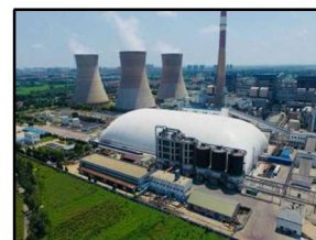
图 7 发电厂煤棚膜结构
